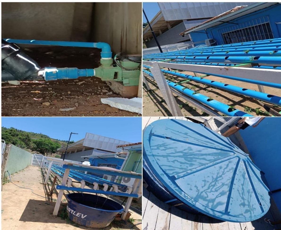
Figura 8- Construção do sistema hidropônico utilizando PVC.
